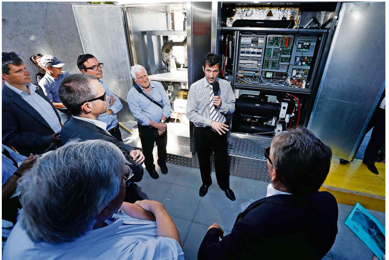
Stefan Bernsdorf, Projektleiter bei Silent-Power, erklärt den Gästen das Kleinkraftwerk Econimo. Bild Stefan Kaiser
